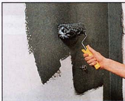
Меховым валиком наносят гидроизолирующий состав на стены душевой кабины ровным слоем.
