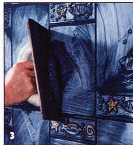
Приготовленным раствором заполняют швы, выполняя кельмой диагональные движения.
