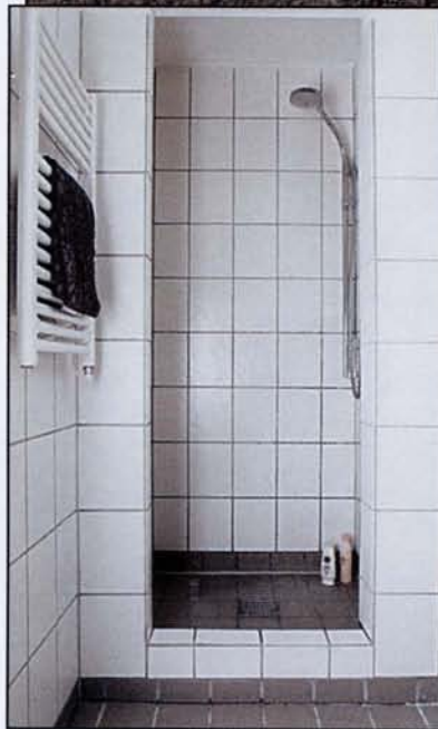
Эта новая душевая кабина построена в удобном месте. Её стены сложены из газобетонных блоков на бетонном цоколе.
