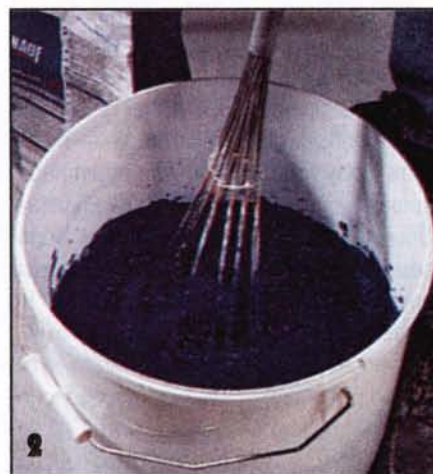
Перемешав порошок с водой, смесь выдерживают в течение 5 минут, после чего перемешивают ещё раз.
