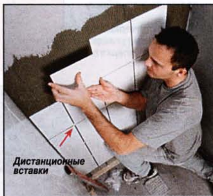
Кафельные плитки приклеивают снизу вверх. Вложенные в швы крестообразные дистанционные вставки фиксируют плитки относительно друг друга.
