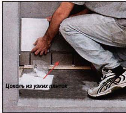
Настенную кафельную плитку начинают клеить от нижнего угла душевой кабины. Опорой для первого ряда настенных плиток служит цоколь из узких плиток.
