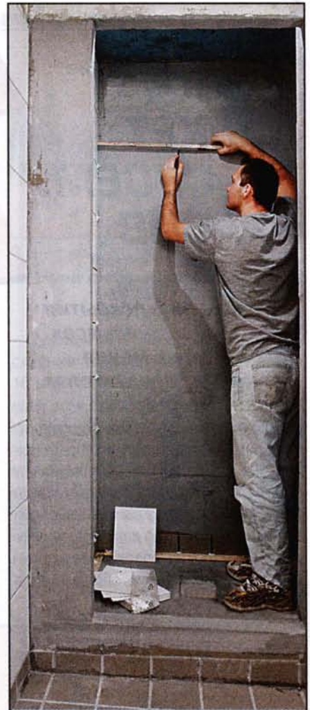
Облицовку стены душевой кабины кафельной плиткой начинают с разметки.
