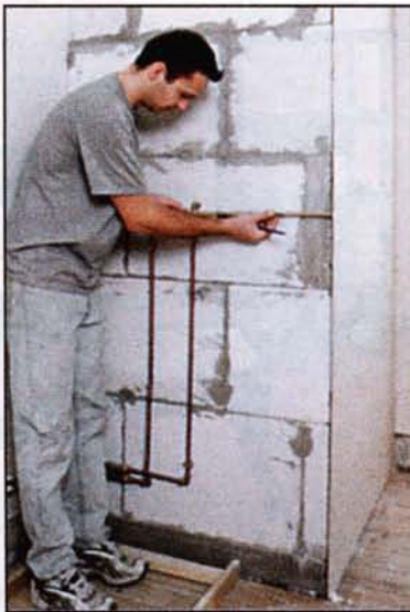
Водопроводные трубы, пройдя сквозь стену, должны попасть в душевую кабину точно в нужном месте.
